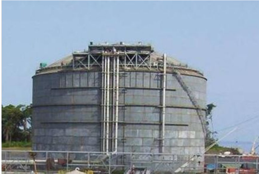
Zbiornik na płynny gaz ziemny (Malabo, Gwinea Równikowa).
