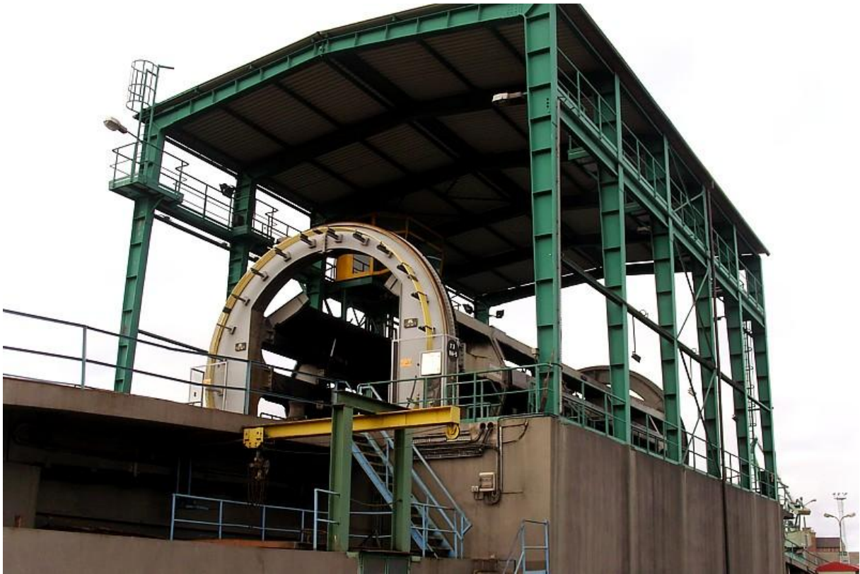
Zdj. Wywrotnica wagonowa boczna
