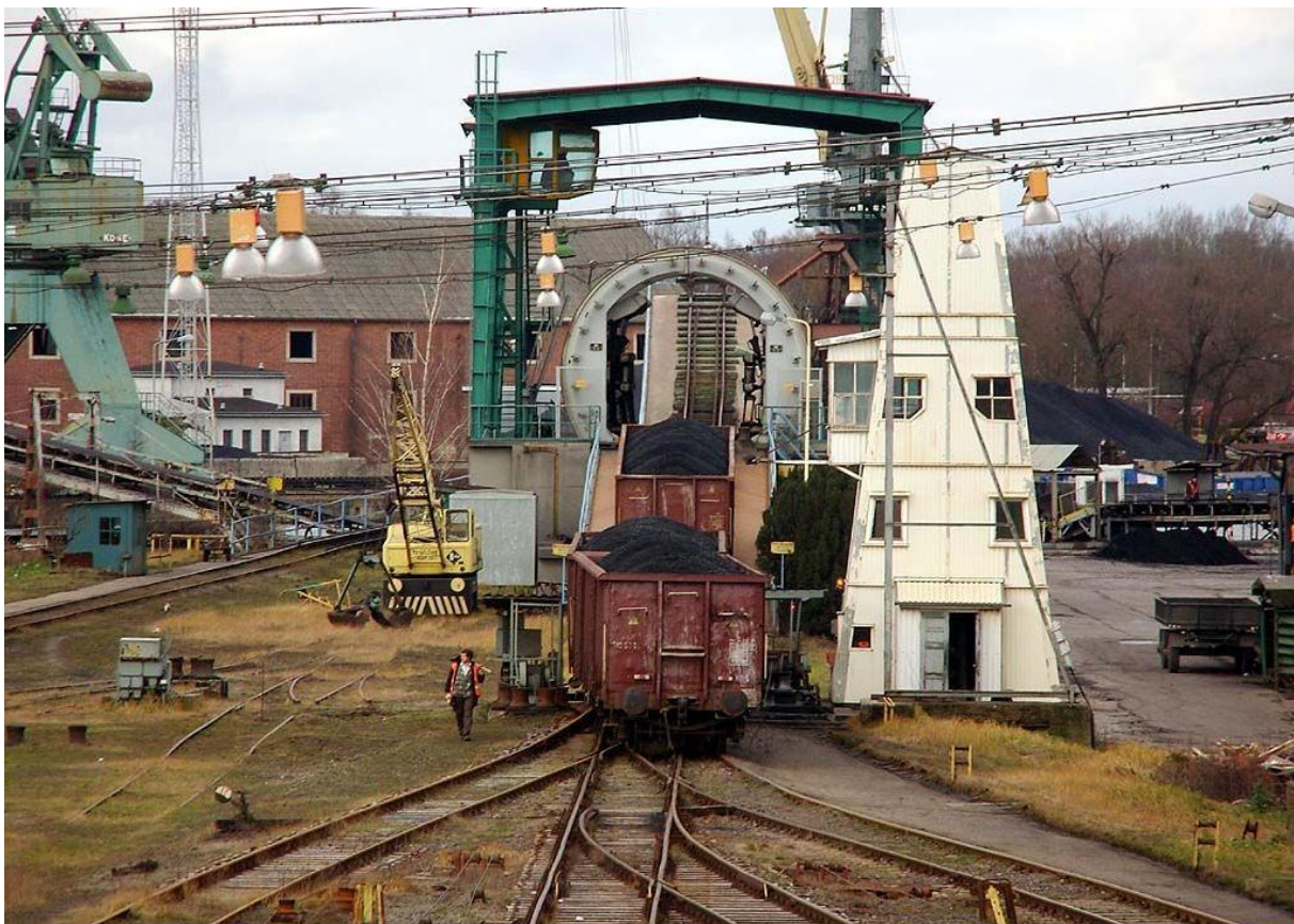
Zdj. Wywrotnica wagonowa boczna
